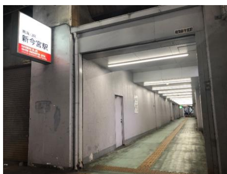
南北通路の様子
