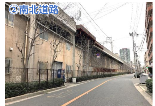
西側（鉄道側）は環境対策のためフェンスが設置され、植樹帯として閉鎖されている。
